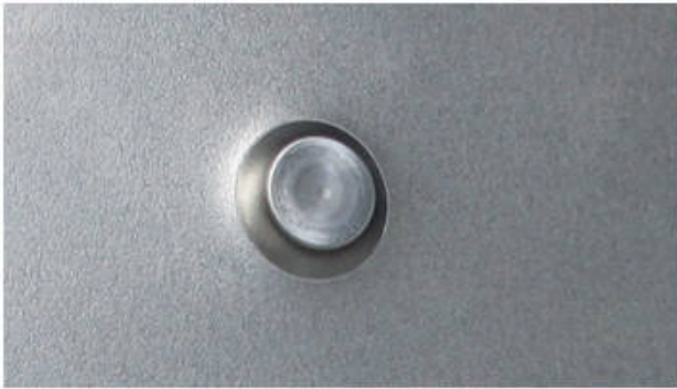
ERGEBNISSE SELBSTBOHRENDE NIETVERLEGUNG
